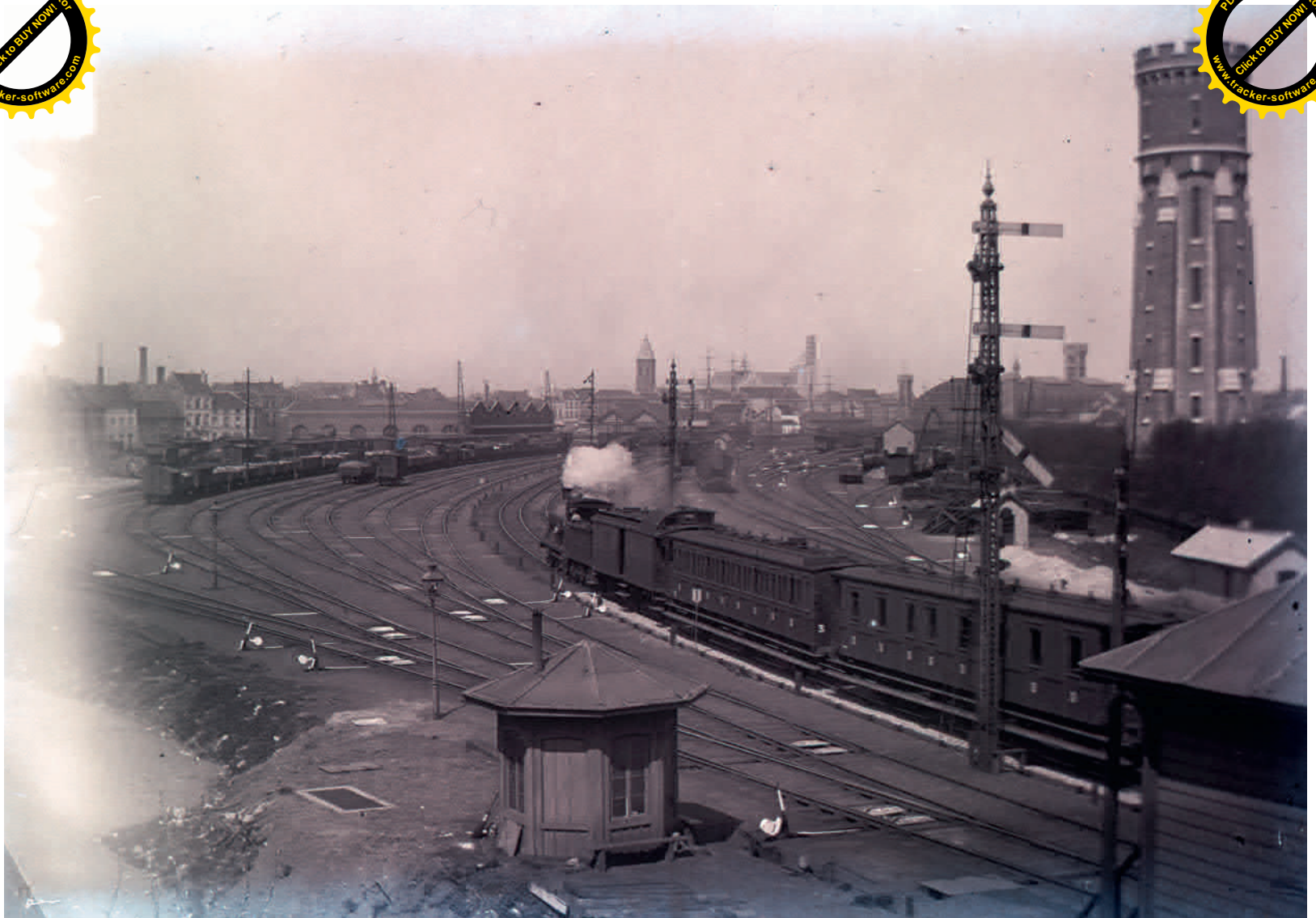
Ostende. Vers les installations maritimes
